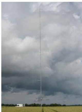
photo 1: Mât de mesure de 60 mètres
